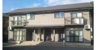
【①外観】女川町宮万石浦住宅(下写真)
