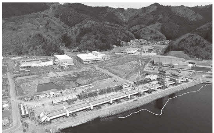
◆組立てが進む出島架橋
