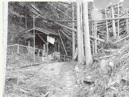
東日本大震災直後の波切不動尊。 津波被害はなかったが、その後の 台風の影響で倒木や土砂崩れの被 害がありました。
