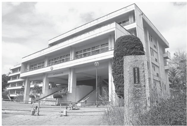
有効利活用が期待される旧女川小学校
