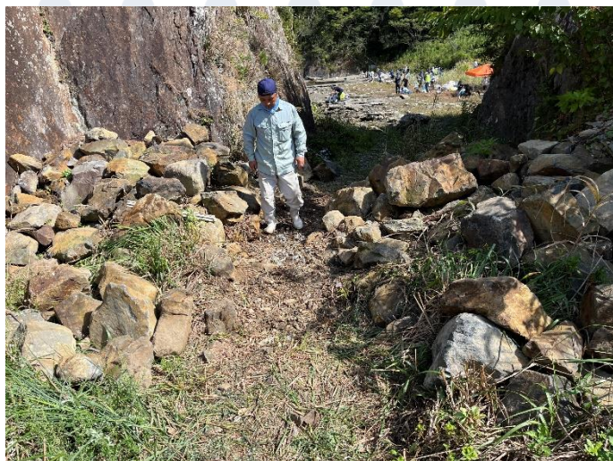
石の撤去作業
