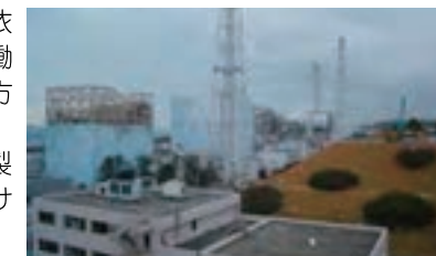
福島第一原子力発電所 写真提供:東京電力ホールディングス(株)
