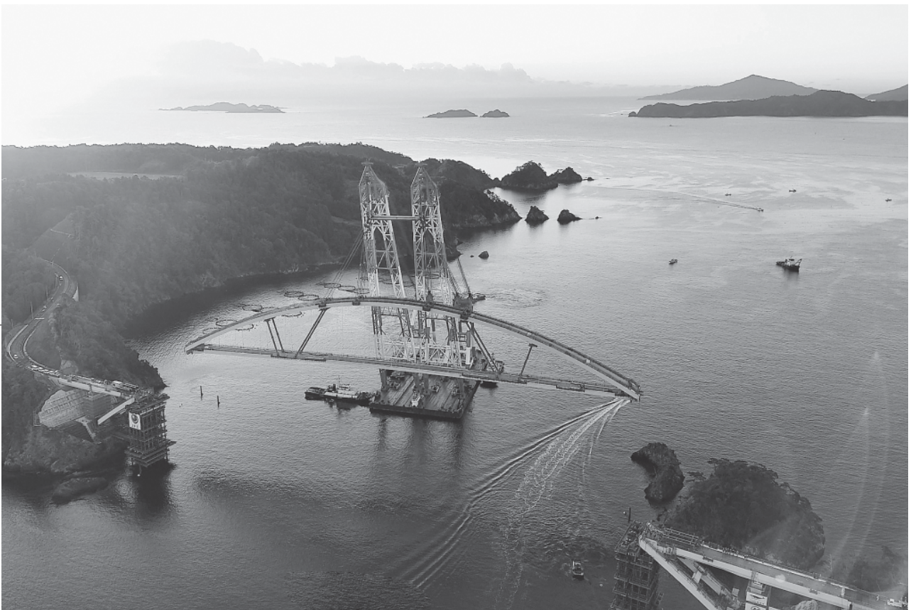
◆令和5年11月に行われた出島架橋建設事業の中央径間架設の様子。令和6年12月の供用開始に向けて準備を進めている。
