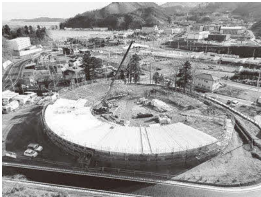
◆工事が進んでいます
