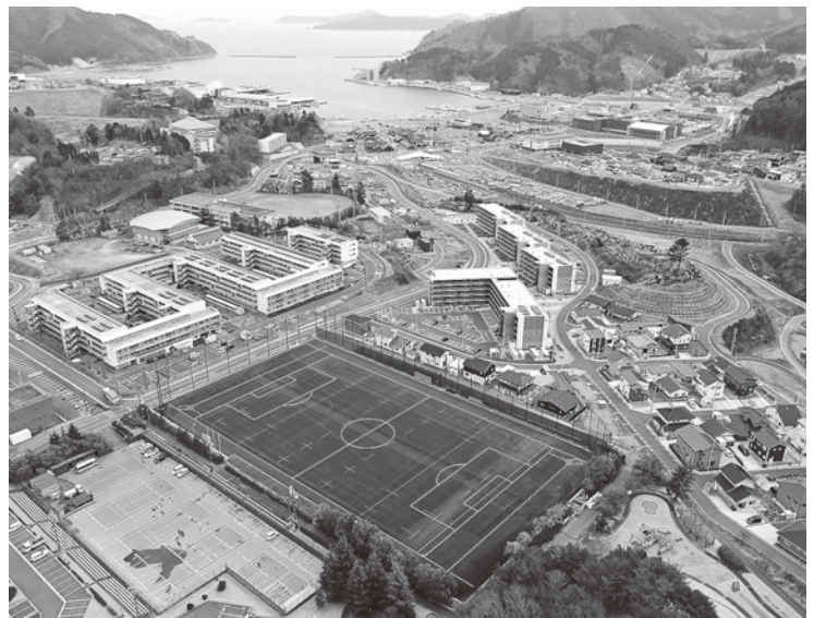
◆完成した多目的運動場
